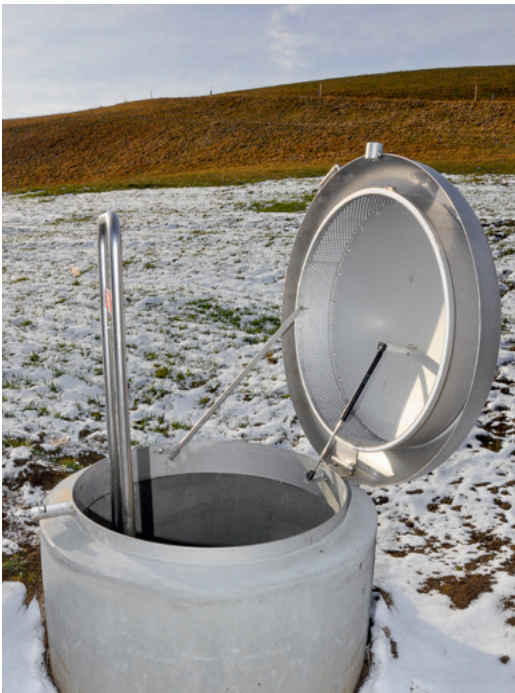
Der hochwertige Sicherheitsdeckel und die Innenleiter sind aus Chromstahl gefertigt.
